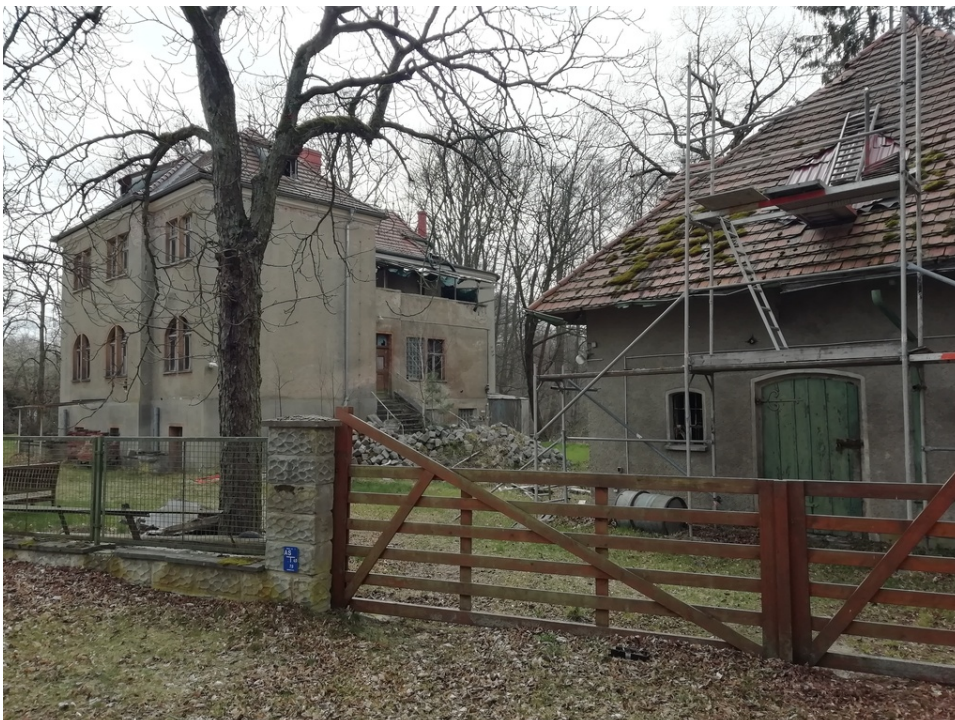
Hauptgebäude mit Nebengebäude (Nina Zellerhoff, 2022)
