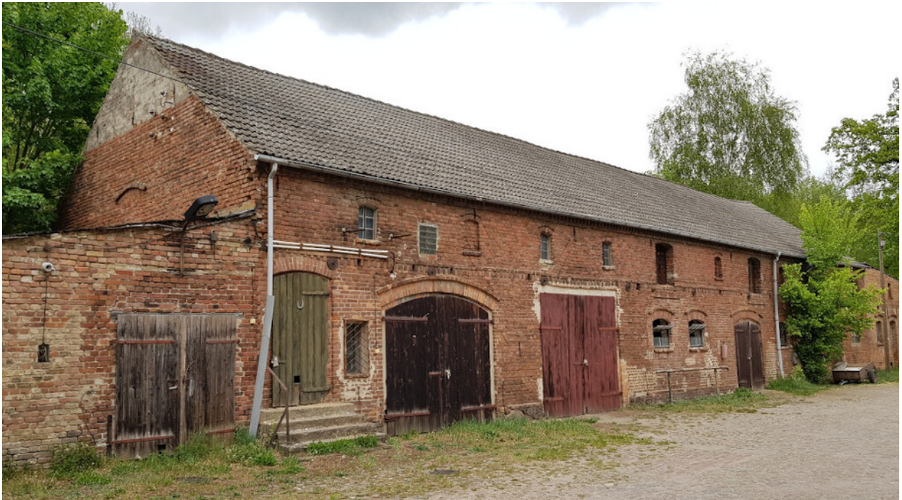
Ehemaliges Landwerk Neuendorf, erhaltenes Stallgebäude (deutlich vor 1930) (Harald Lordick, 2019) © CC-BY-SA-4.0
