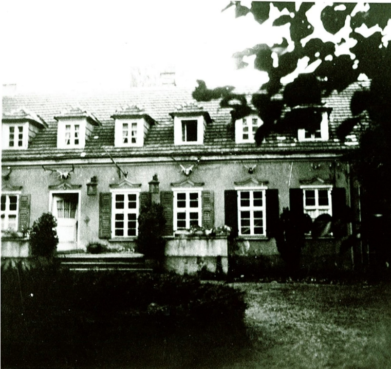
Landwerk Steckelsdorf – Ausbau, Sommervilla von vorne (unbekannt, unbekannt) © Archiv Kulturzentrum Rathenow GmbH
